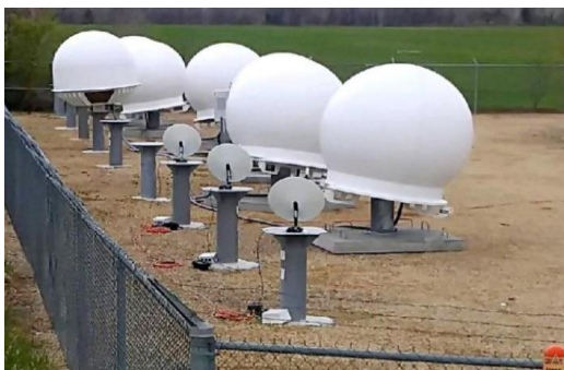
Рис. 3. Шлюзові (Gateway) системи Starlink.
